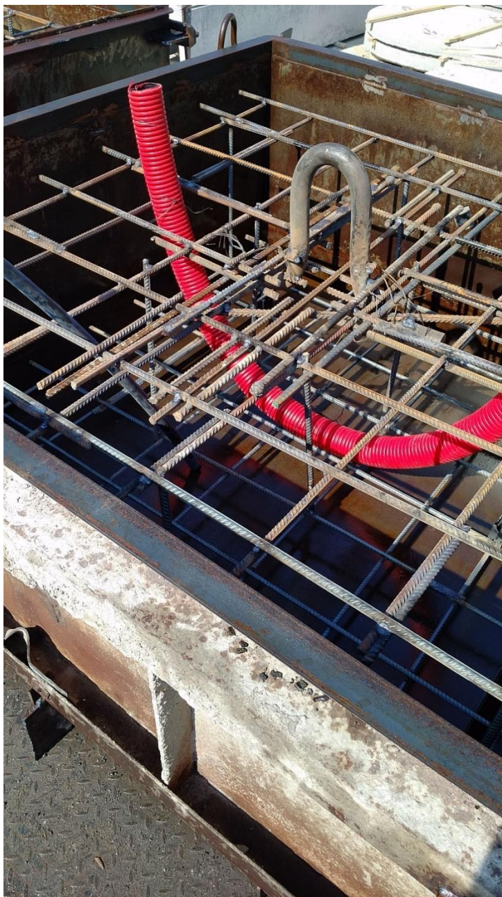
Рисунок 10 – Бетонный якорь в процессе изготовления
