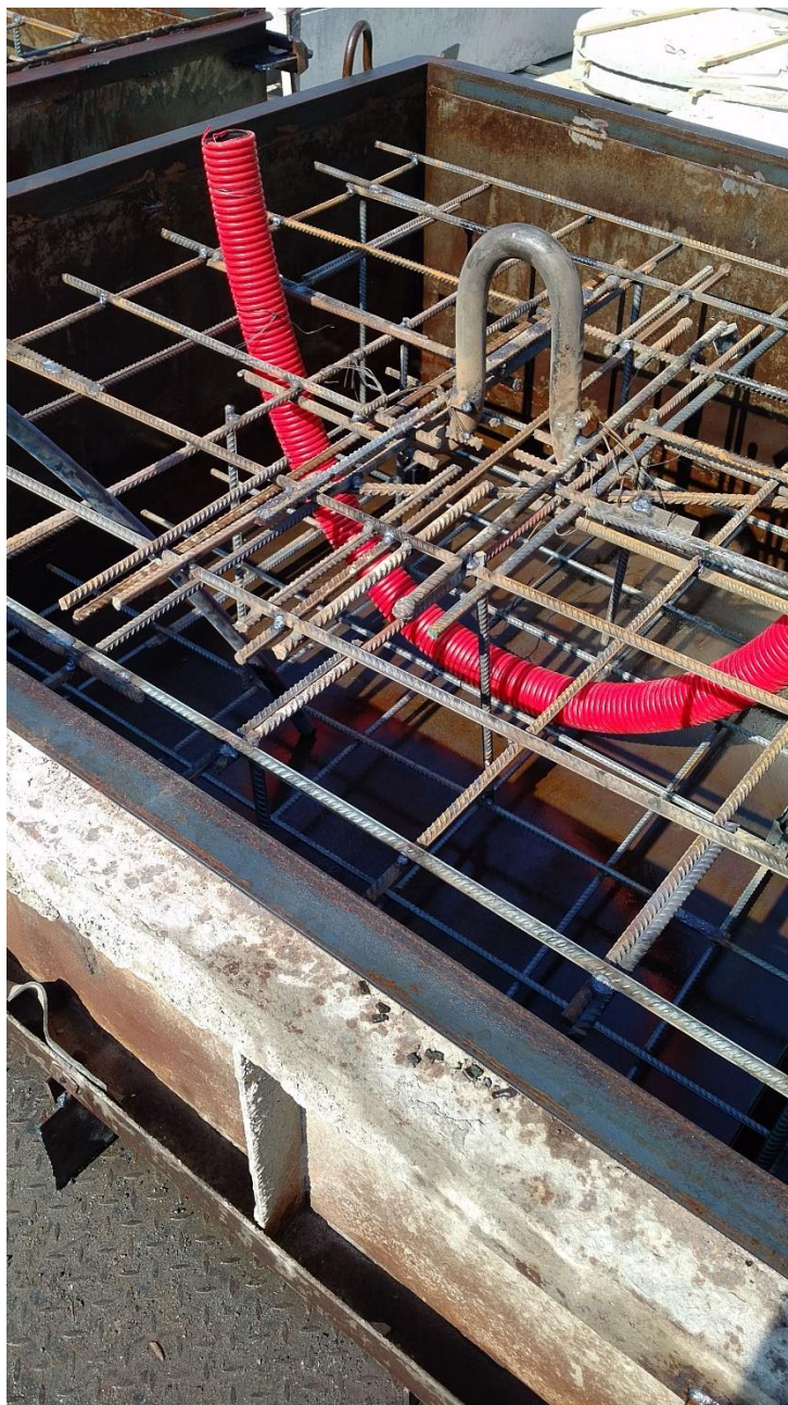
Рисунок 10 – Бетонный якорь в процессе изготовления
